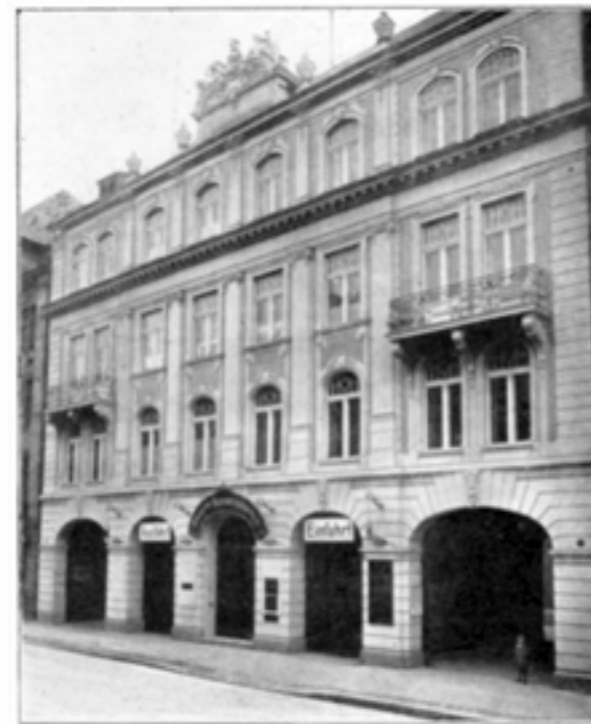
Abb. 64: Haus der Bernburger Str. 23 a, Foto von Gertrud Sincelius, aus: Jahresbericht 1928/29 , S. 3. (Archiv der UdK Berlin, Bestand 4, Nr. 34)
