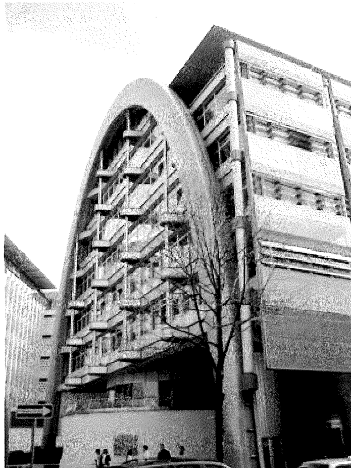
Abb 1.1 Die Form der linearen Bögen des Ludwig-Erhardt-Hauses in Berlin, 1988, an denen die Decken aufgehängt sind, prägt das Gebäude von Architekt Nicholas Grimshaw.
