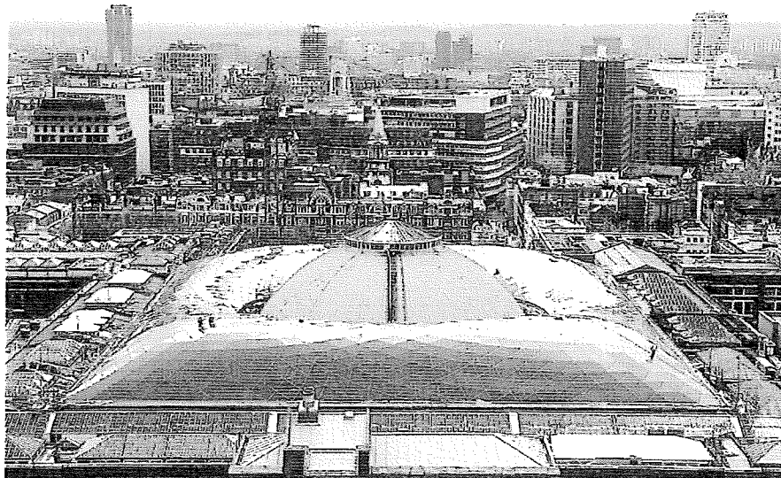
Abb. 5.64 Blick auf das noch im Bau befindliche Dach in London.
