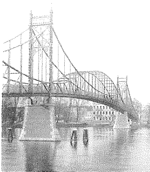
Abb. 2.11 Der Kaisersteg in Oberschöneweide, von Heinrich Müller-Breslau nach der Biegemomentenlinie entworfen.
