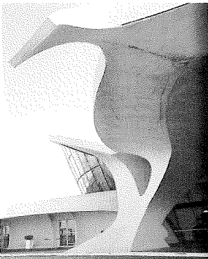
Abb. 2.42 Detail einer Stütze des TWA-Terminals. Die Auflagerkräfte von zwei Schalen laufen hier zusammen.
