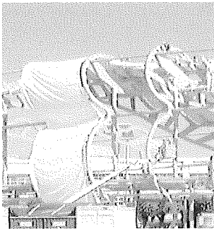
Abb. 4.10 Für die einfach gekrümmte Hülle der Dynaform wurde eine Membran gewählt.
