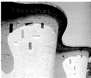
Abb. 5.34 Eladio Dieste stellte gekrümmte Formen aus Mauerwerk her.
