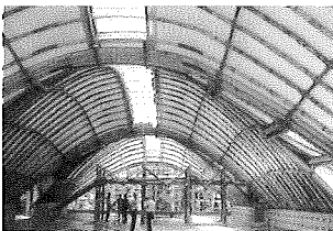
Abb. 5.6 Innenansicht des Werkstattgebäudes der Hooke Park Schule.
