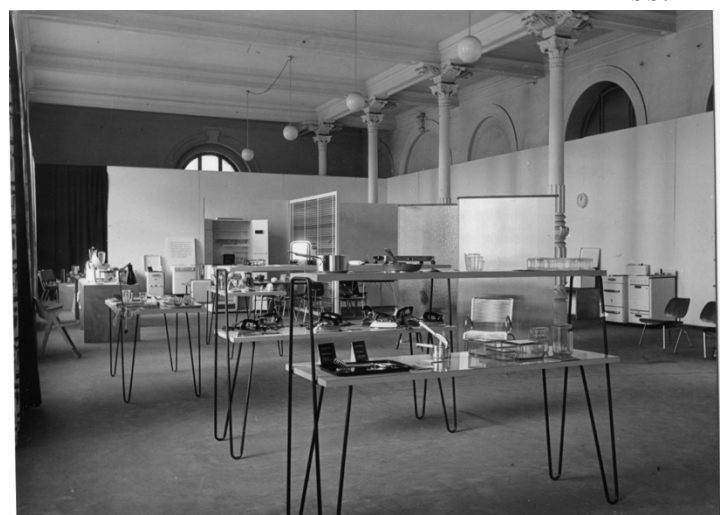
Ausstellung Schönheit der Technik Stuttgart 1953, Abteilung „Die gute Industrieform im Bereich der Architektur und Wohnkultur“
