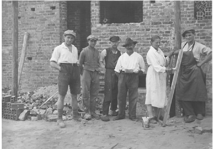
Beim Bau des Hauses von Friedrich Engemann, Herbert Hirche rechts außen, um 1931
