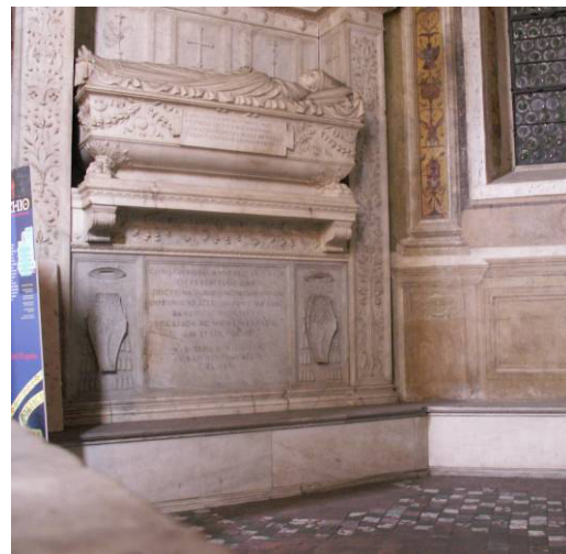
Abb. 52a: Detail, umlaufende Sitzbank in der Cappella della Rovere
