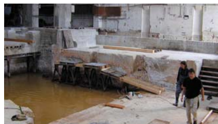
Errichtung der Brücke: Hannes, Ivo; rechts ein Teil der Treppe
