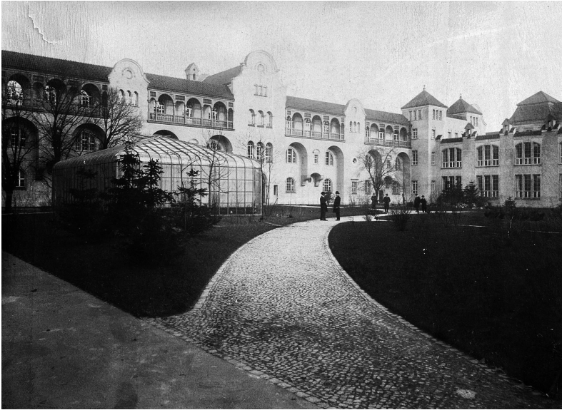
Abb. 5: Innenhof (mit Glashaus) im Neubau der Hochschule für die bildenden Künste in Charlottenburg, Hardenbergstraße 33 (nach 1902)
