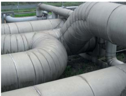
Abbildung 1. Links: Typische Verzweigung der Rohrleitungen innerhalb einer Verdichterstation Rechts: Exemplarischer Schaltzustand der Ventile und Verdichter (rot = aus, grün = an) in einer Verdichterstation
