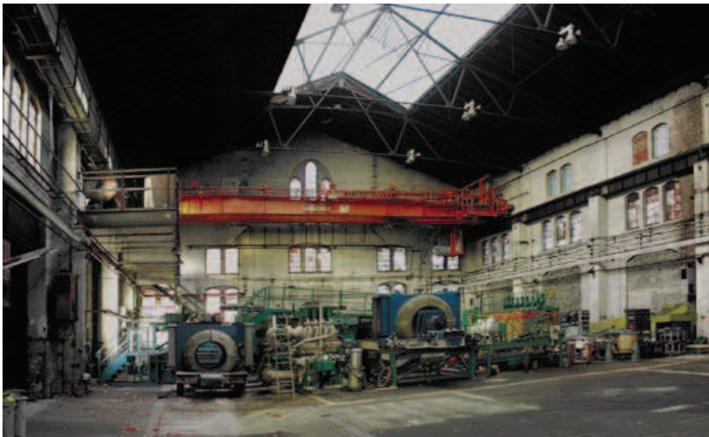
Die geschossfreie Halle 10 vor dem Umbau durch die Architekten des Büros Chestnutt_Niess. Die Doppel-T-Stahlträger der Kranbahn durchziehen noch heute die gesamte Halle. Foto: Chestnutt_Niess
