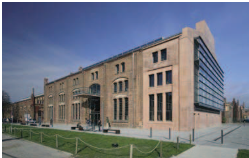
Die ehemalige Maschinenhalle diente einst als Auslieferungshalle für Dampflokomotiven der Marke Schwartzkopff. Der zeitgenössische Anbau aus rotgefärbtem Sichtbeton gibt der Giebelfront eine gemeinsame Flucht. Foto: Marcus von Amsberg
