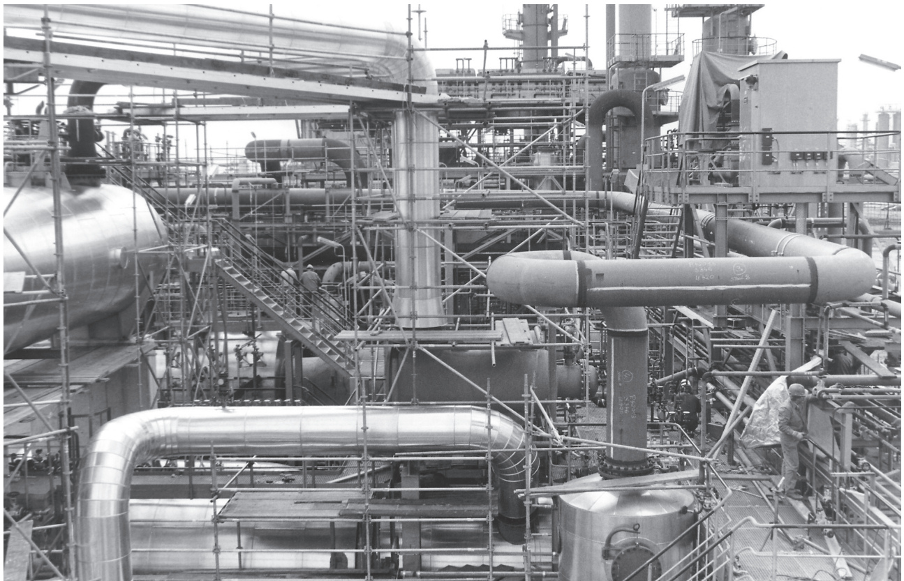
Bild 6: Montagefortschritt und Arbeitsdichte (PCK Schwedt AG)
