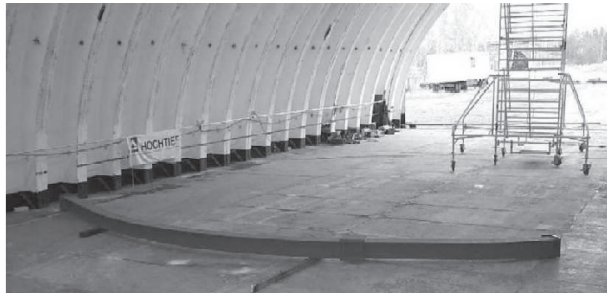
Erste Kranbahnteile werden eingelagert
