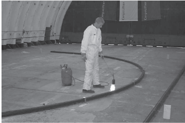
Robby beim Wärmen des PE-Rohrs.
