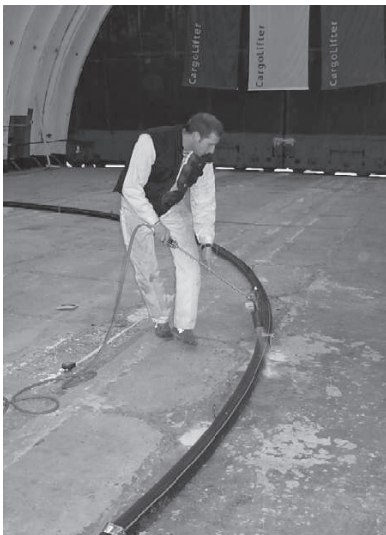
PE-Rohre werden gewärmt und in Bogenform gebracht.
