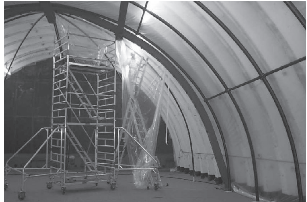
Hangar wird mit Folie bespannt.
