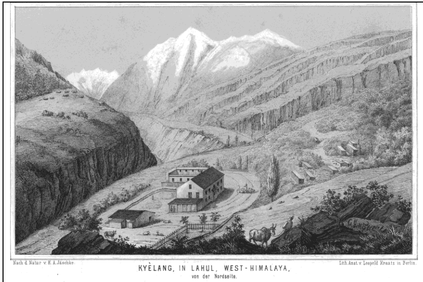
Bild 1: Ansicht der Missionsstation (Nordseite)
