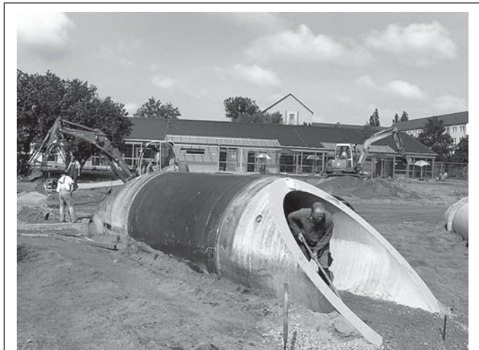
Letzte Handgriffe verrichten gegenwärtig Mitarbeiter eines Landschaftsbauunternehmens an den Außenanlagen von Ortsteilzentrum und Kita. Pünktlich zum vorgesehenen Übergabetermin am 11. September sollen diese Arbeiten enden.
