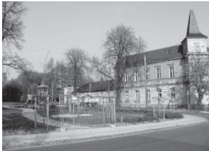
Es geht voran: Auf der Baustelle des neuen Spielplatzes montierten Mitarbeiter der Firma Cleanaway Hoyerswerda Ende Oktober letzte Spielgeräte. Bis Ende November soll die Bepflanzung folgen. Spätestens im Frühjahr lädt dann der neue Spielplatz Kinder zu einem Besuch ein. Der bisherige überdimensionierte Spielplatz soll als Bauland verwertet werden.
