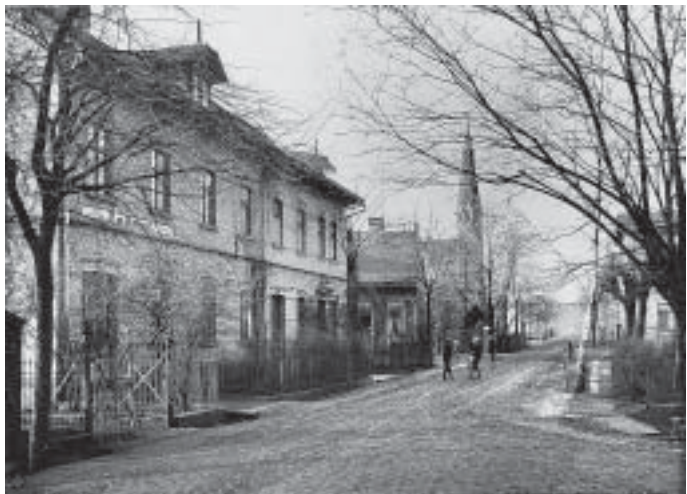
Ein Bild aus alten Zeiten: Anno 1928 war die Annahütter Bahnhofstraße noch völlig unbefestigt, an beiden Straßenrändern verliefen offene Gräben. Links ist das damalige Postamt zu erkennen, im Bildhintergrund erhebt sich die Henriettenkirche.
