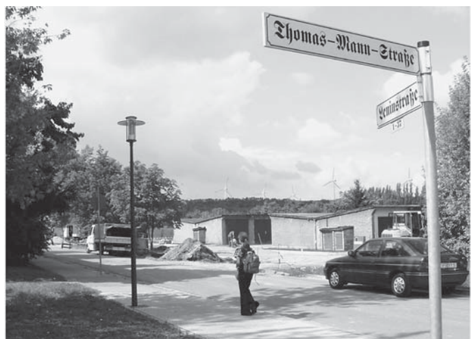
Hier wird nicht nur abgerissen, sondern auch Vorbereitungen für eine Nachnutzung der freigeräumten Flächen geschaffen. Nach der Umgestaltung der Thomas-Mann-Straße gelang es der Gemeinde nun auch, für die Leninstraße und die Clara-Zetkin-Straße eine Finan-
