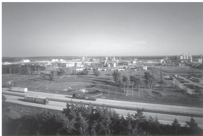
Der Standort der BASF Schwarzheide GmbH zeichnet sich durch eine moderne und kostengünstige Infrastruktur aus. Das Transportaufkommen per Straße und Schiene lag 2003 bei rund 1,37 Mio. Tonnen. Zu den logistischen Vorteilen zählen die hervorragende Anbindung durch den direkten Autobahnanschluss an die A 13 und über das Kombiterminal an das Netz der Deutschen Bahn.
