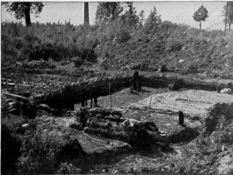
3. Haus Ib von Osten. Rechts der stehengebliebene Rest der Isolierschichten. Links der Stall
