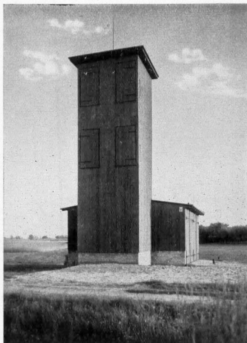
3. Marienthal, Feuerwehr-Gerätehaus mit Steiger- und Schlauchtrockenturm. Erbaut 1938
