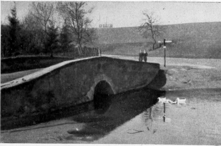
5. Ansicht der Knehdenener Fließbrücke
