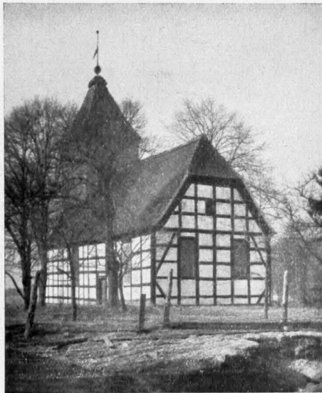
4. Die Fachwerkkirche zu Dargersdorf (Archivaußn.)
