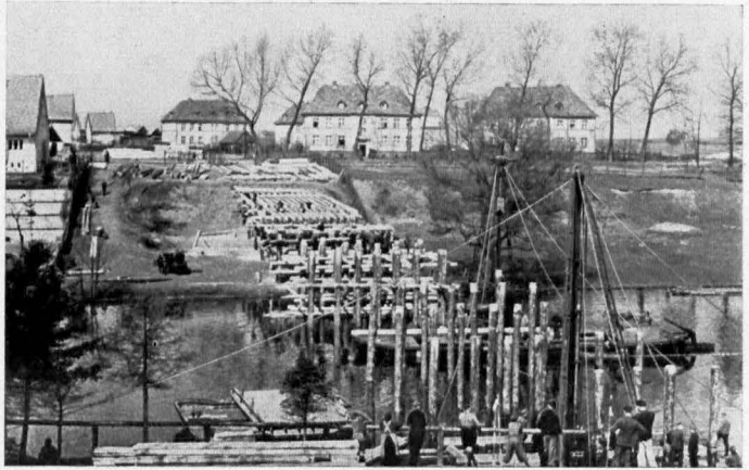
4. Grundierung der Pionierbrücke in Templin
