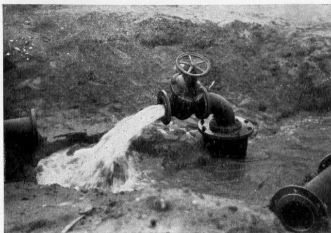
4. Zur Löschwasserbeschaffung in Zehdenick, Bohrung für das zweite Wasserwert im Erdstrich der Ziegelei Schmidt & Co., Nähe Forsthaus Wolfsgarten. Starker artesischer Auftrieb 1938
