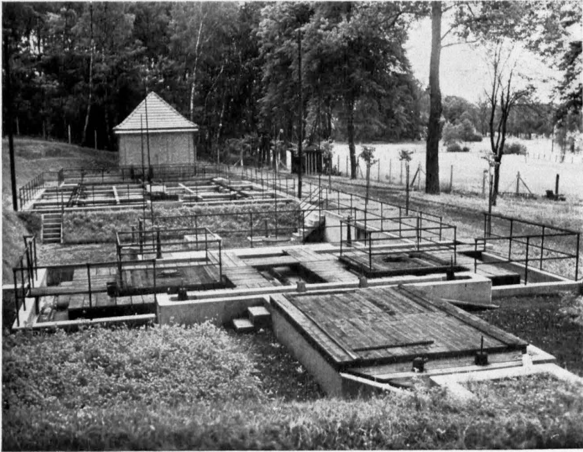
Abb. 2. Gesamtansicht der fertiggestellten Kläranlage der Stadt Templin
