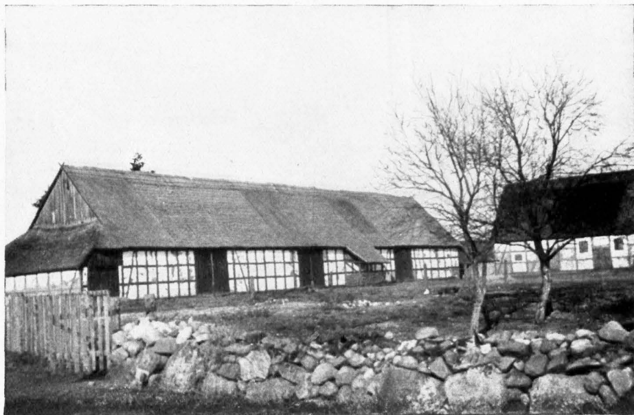
Abb. 7. Bröddin. Alte Wirtschaftsgebäude aus Fachwerk
