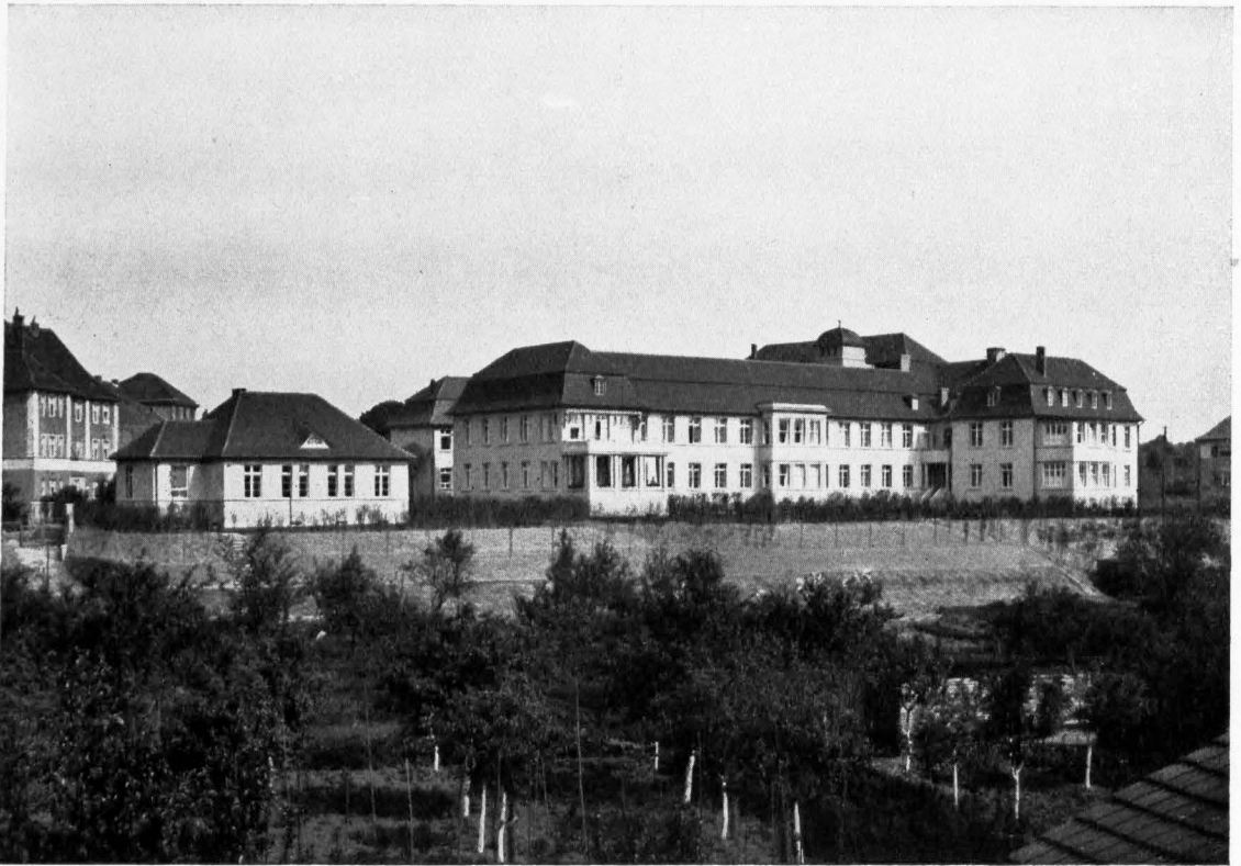
Abb. 10. Templin. Kreiskrankenhaus, Gartenfront mit Isolierpavillon
