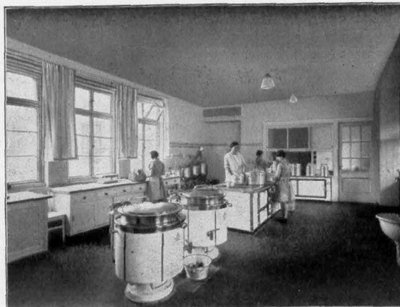
Abb. 9. Templin. Kreisrankenhaus, Zentralküche
