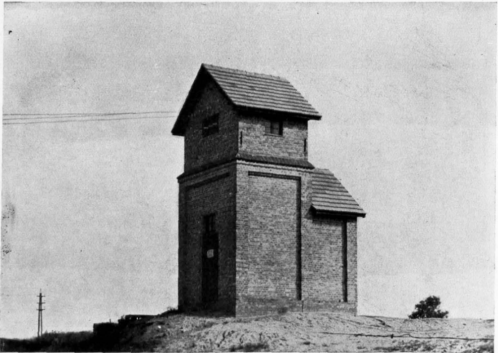
Abb. 6. Zehdenick. Transformatoren-Station einer Ziegelei. Aufnahme 1927
