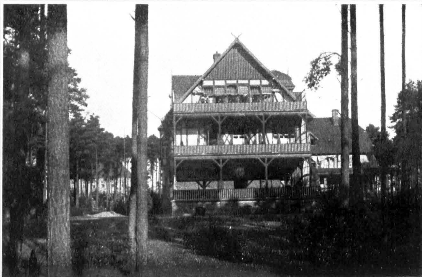
10. Hohenlychen. Heilanstalt für äußere Tuberkulose. Haus 7a.
