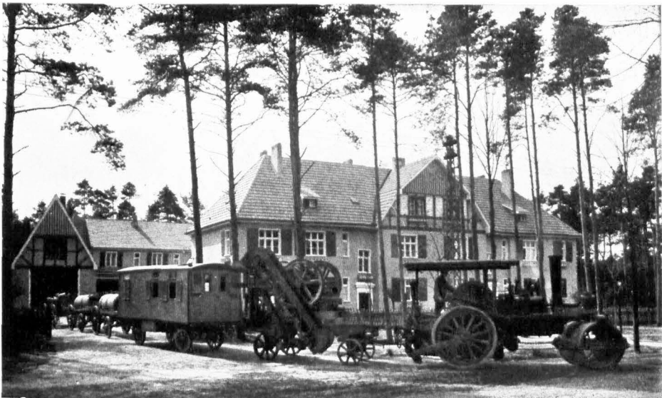
Abb. 1. Der Walzenzug der Kreisverwaltung Templin verläßt zu Beginn der Walzarbeit sein Winterquartier. Hinter der Walze rechts das 1923/24 erbaute Kreiswohnhaus.
