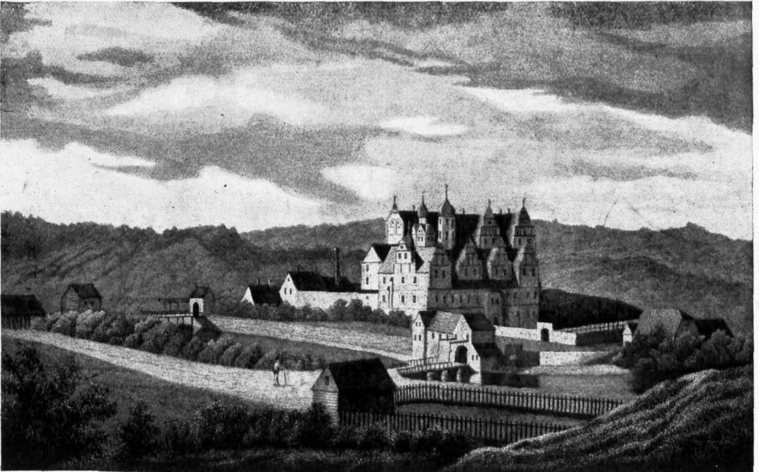
1. Schloß Boizenburg. Ansicht nach Merian Anno 1652. Nach einem Stahlstich von Schulir 1837 (Sammlung Rudolf Schmidt-Eberswalde).
