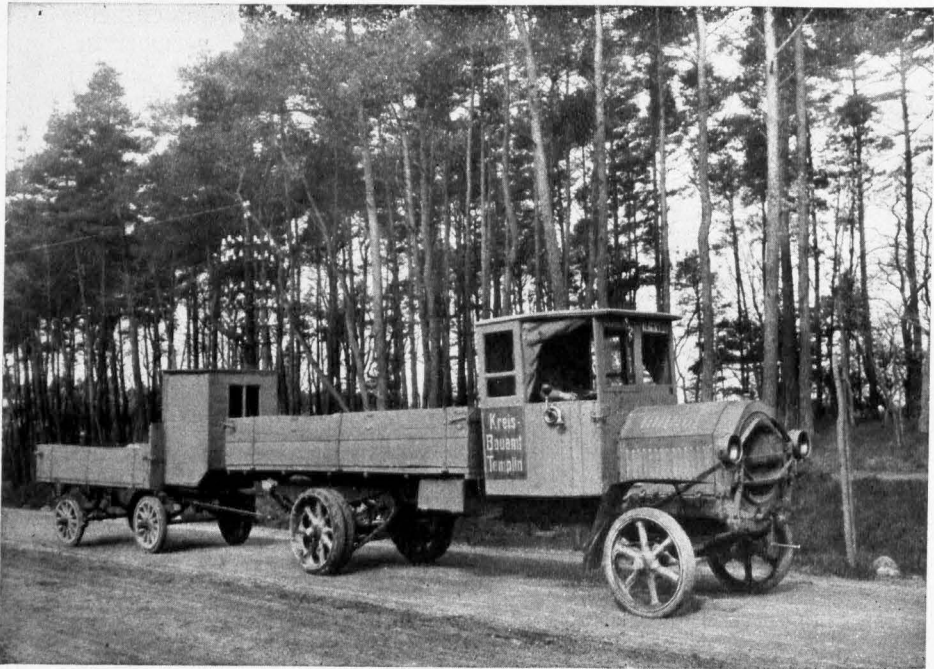
Abb. 2. Kreisverwaltung Templin: Lastkraftwagen mit Anhänger, der das für den Chausseebau erforderliche Material zu den Verwendungsstellen bringt
