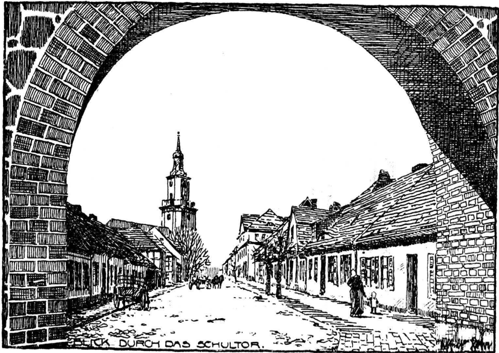
10. Templin. Blick durch das Schultor 1924. Nach einer Zeichnung von Regierungs- und Baurat Rohr, Templin
