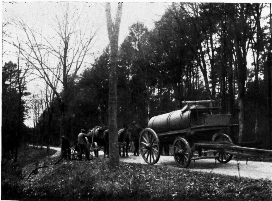
Abb. 5. Kreisverwaltung Templin: Das notwendige Wasser für den Betrieb wird einem Chausseeegraben durch die mitgeführte Pumpe entnommen.
