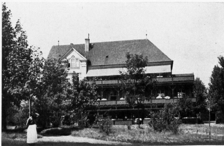
11. Hohenlychen. Heilanstalten für äußere Tuberkulose. Haus 7b.
