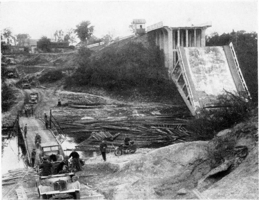
Der Vormarsch geht über die Behelfsbrücke weiter vorwärts.
