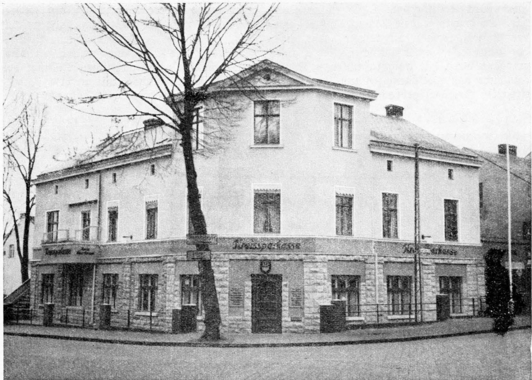
Sparkassengebäude der Zweigstelle Rüdersdorf der Kreissparkasse des Kreises Niederbarnim
