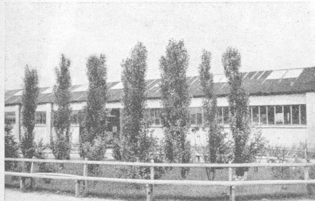
Bild 3: Hof mit Anlage der Küchenmöbelfabrik Paul Bergemann, Klosterfelde (Aufn. Bergem., K.)
