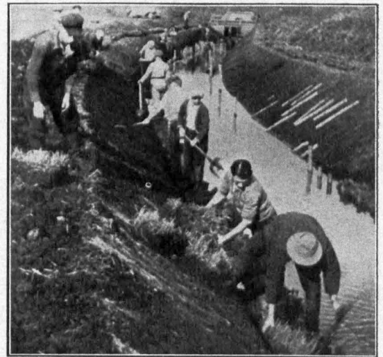
Erdarbeiten am Murgaben
