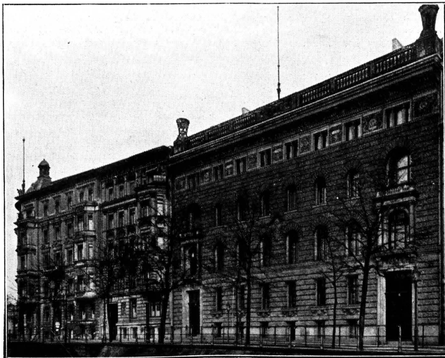
Niederbarnimer Kreishäuser in Berlin NW, Friedrich-Karl-Ufer 56 und Alexander-Ufer 1
