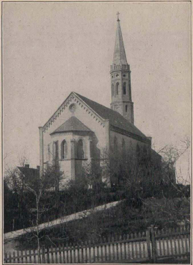
Woltersdorf: Die 1855 neu erbaute Kirche.
