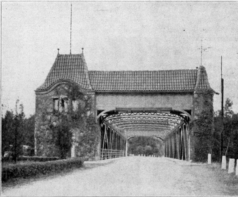
Rechtecker Wassertorbrücke von der Anfahrtsstraße aus.
