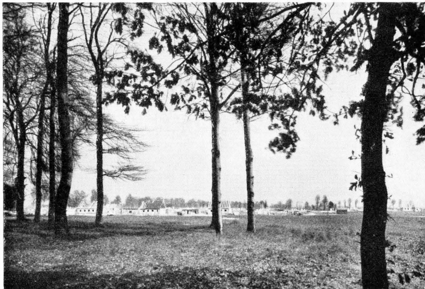
Bild 1. Blick auf die im Bau begriffene Dietrich-Eckart-Siedlung in Finow (Messingwerk)
