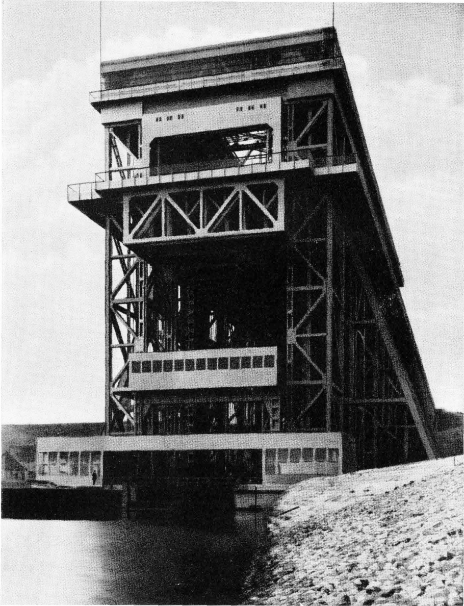
Bild 1. Gesamtansicht des Hebewerkes, von der Freienwalder Seite gesehen
