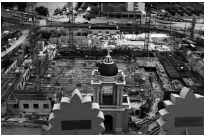
Blick von der Nikolaikirche auf das Baugeschehen: Stand der Arbeiten am 25.7.2011
