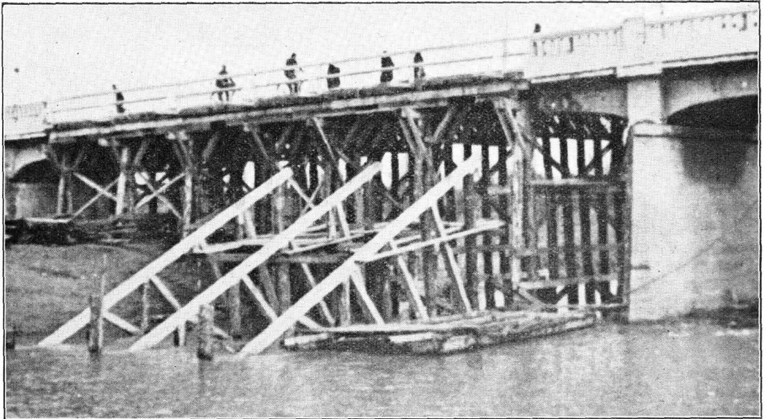
Die bei Gottschalkowich durch Sprengung zerstörte Weichsel-Brücke nach behelfsmäßiger Wiederherstellung durch Nothelfer
