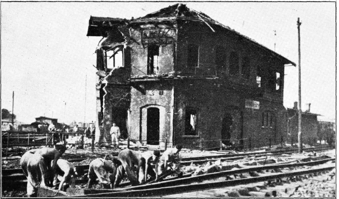
Zerstörtes Stellwerk auf Bahnhof Tarnowitz. Nothelfer beim Ausbau von Schienen.
