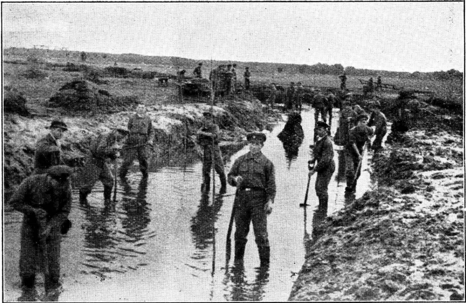
Das Flussbett wird vertieft und verbreitert.
