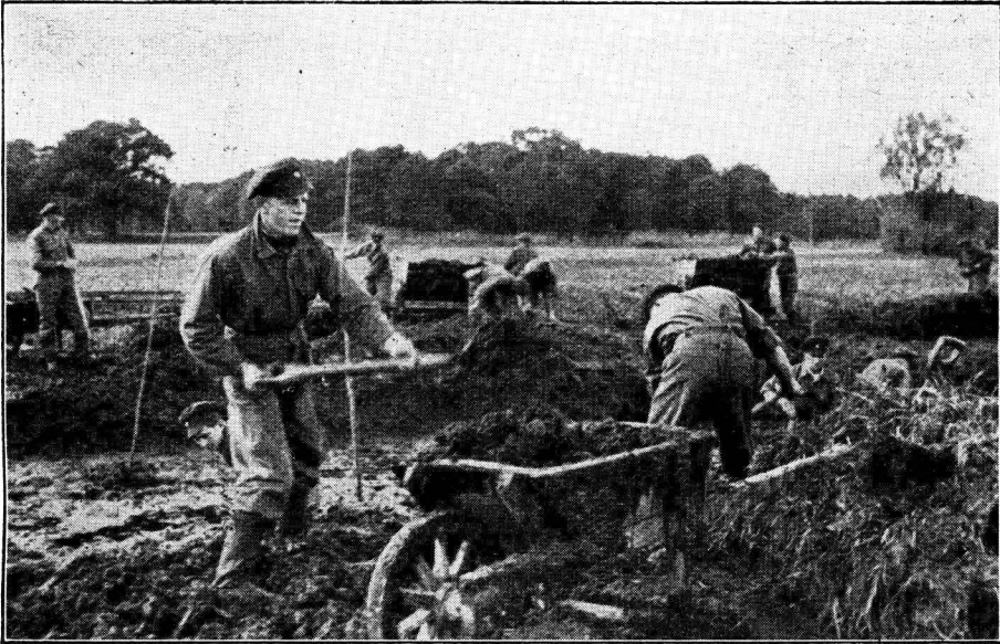
Die Spreamündung wird verlegt.
