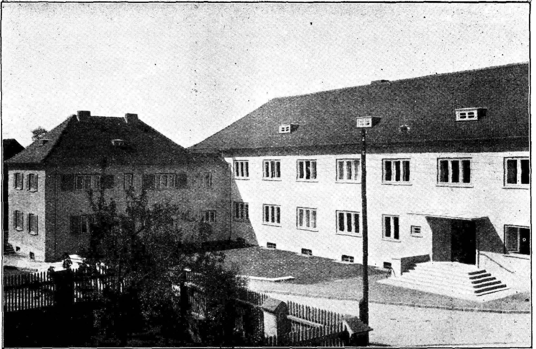
Das neue Amtsgerichtsgebäude.
