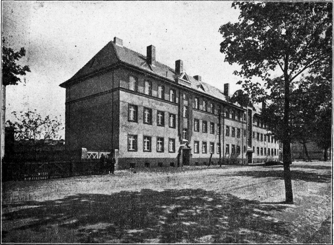
Für Bauverein „Eigenes Heim“ der Schupo Cottbus von der Siedlungsgesellschaft Brandenburg m. b. H. ausgeführt.
