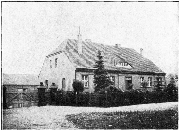
Der nach dem Brande 1822 erbaute Lehnsschulzenhof zu Sarlitz
