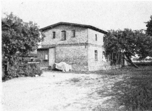
Altes Arbeiterhaus (Kaserne) auf Gut Bärwinkel bei Quappendorf
