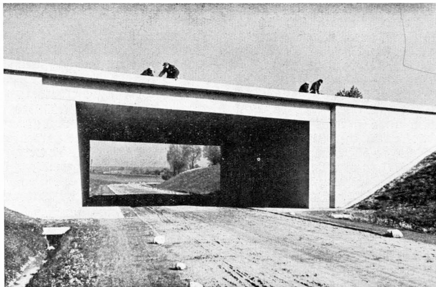
Unterführung der Petersdorf-Müllroser Chaussee
