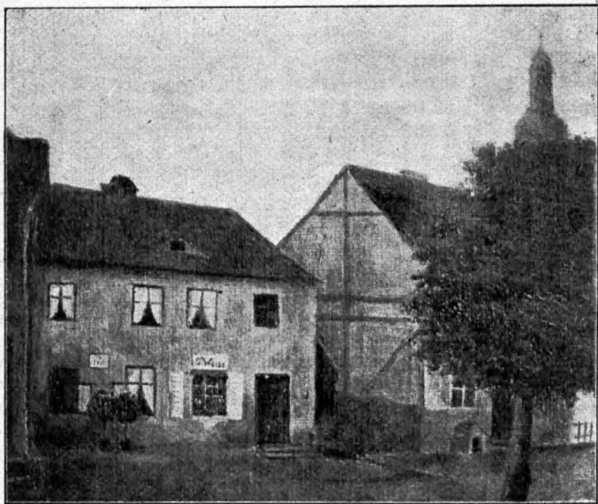
Altes Wohnhaus K. Weises in Freienwalde a. D.
