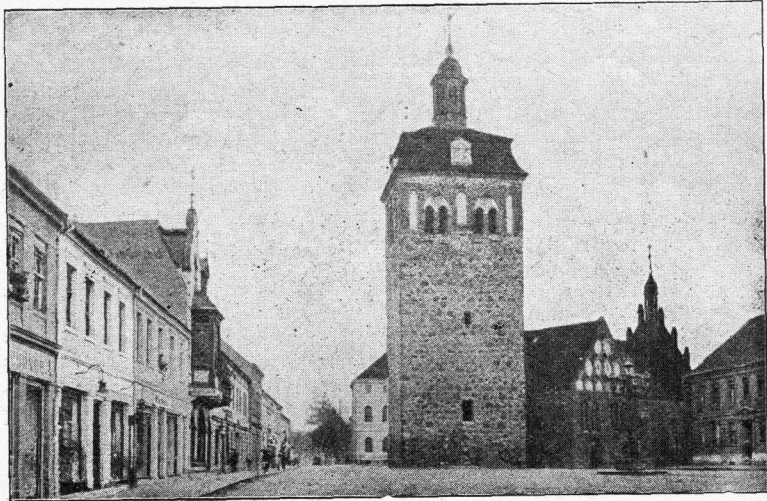
Turm auf dem Marktplatz in Luckenwalde.
