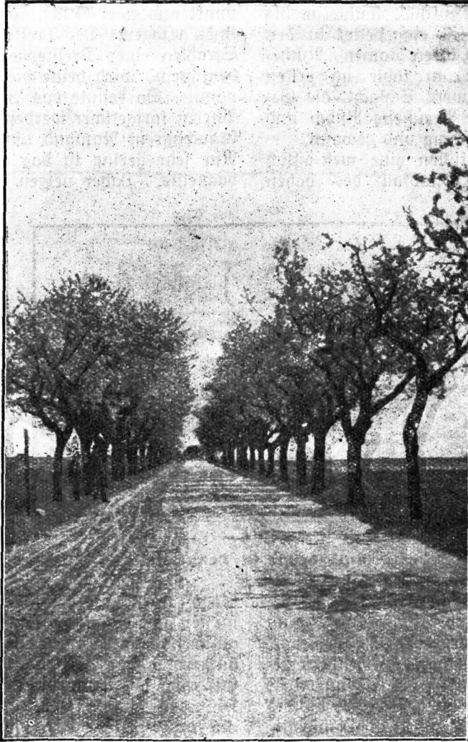
Straße nach Dahme.
