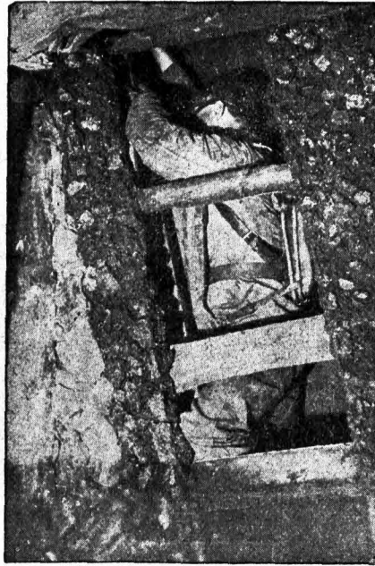
Die müßelige Rettungsarbeit in den engen Schächten.
