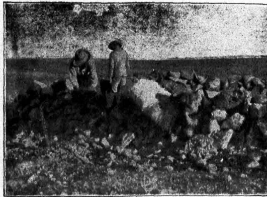
Deutsche Soldaten beim Bau einer Vorpostenschanze gegen die Witbois.
