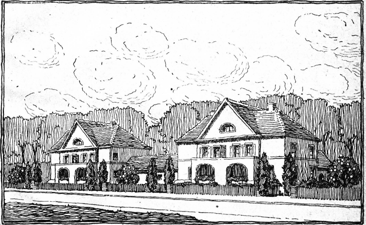
Abb. 1. Vierhausgruppe, Meisterhäuser in Ketschendorf. Architekt Karl Dettinger.
