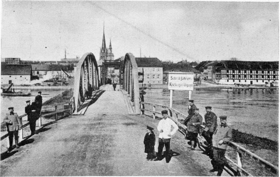
Abb. 6. Schwedt. Ansicht der Oberbrücke im Jahre 1913. Aufnahme Alfred Schwinger (Schwedt)
