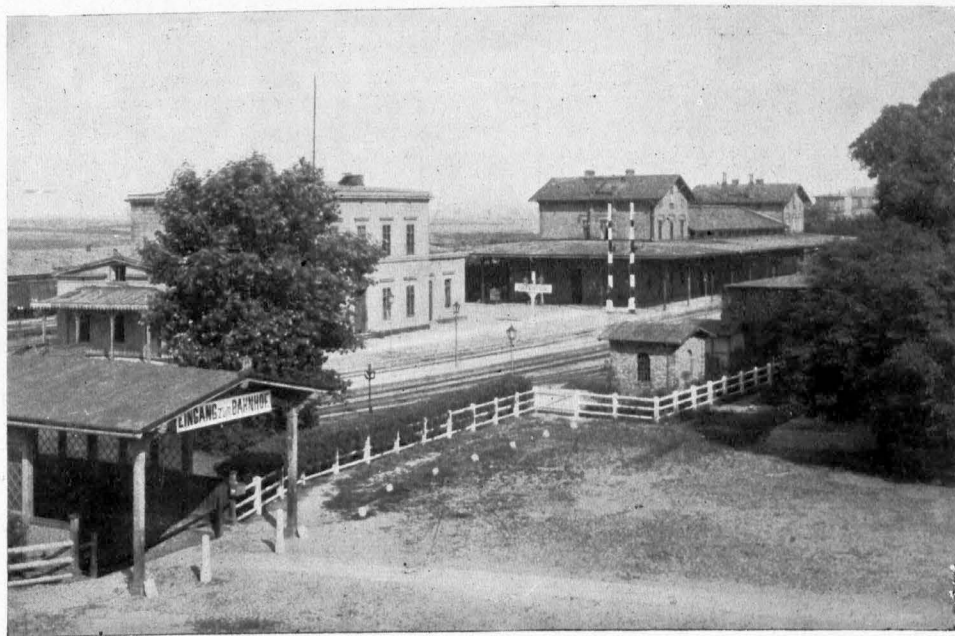
2 Angermünde. Ansicht der Bahnhofsbaulichkeiten im Jahre 1890. Die Eisenbahnzüge verkehren noch über den heutigen Bahnhofsvorplatz. (Aufnahme F. Albert Schwarz)
