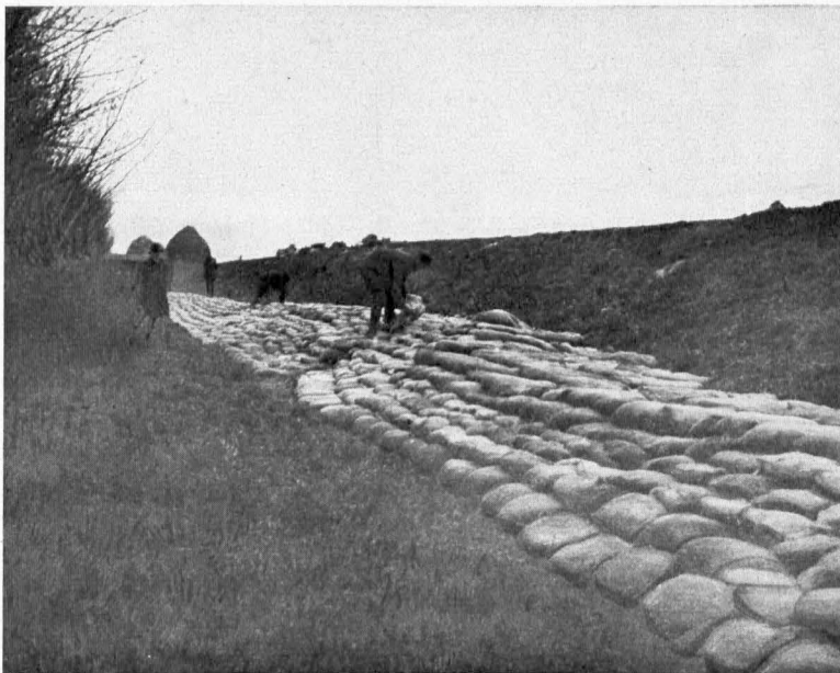
Abb. 6. Stolper Polderdeich: Sandsackpackungen gegen Durchquellungen
