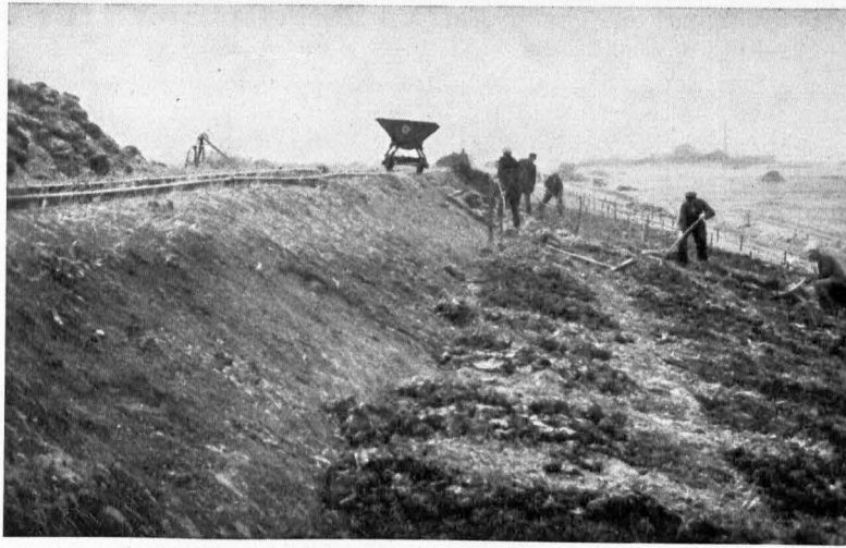
Abb. 10. Deich Stützkow-Schwedt. Abflachen der Böschung, Aufbringen von Mutterboden und Rasen
