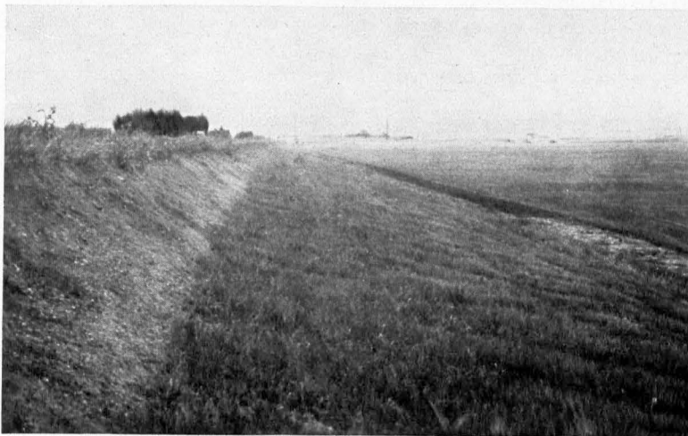
Abb. 11. Deich Stützkow-Schwedt. Fertige begrünte polderseitige Böschung
