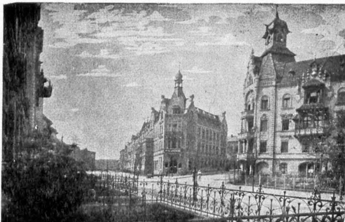
Abb. 4. Eberswalde. Neue Apotheke Ecke Kaiser-Friedrich- und Carlstraße (mittelster Häuserblock auf dem Bilde, Stirnseite)
