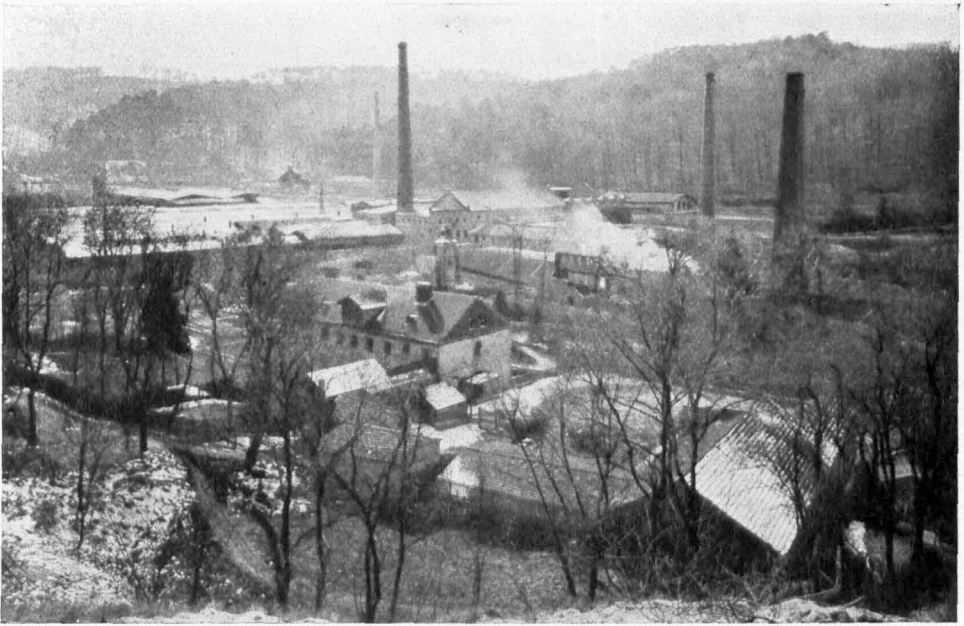
Abb. 12. Ziegelei Alaunwerk bei Bad Freienwalde (Oder). Aufnahme April 1929
