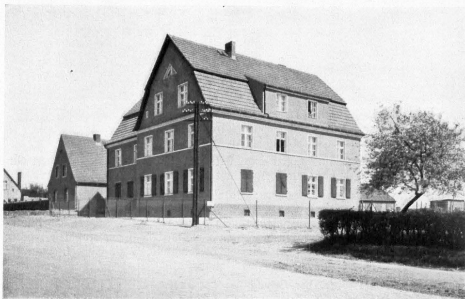
Abb. 3. Ladeburg. Gemeinde-Neubau. Aufgenommen Mai 1928
