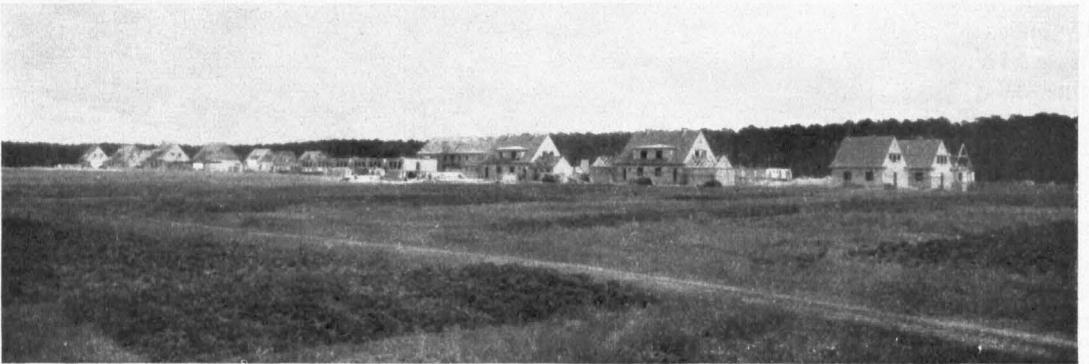
Abb. 3. Siedlung Finow. Das Baugelände Ende Juni 1929
