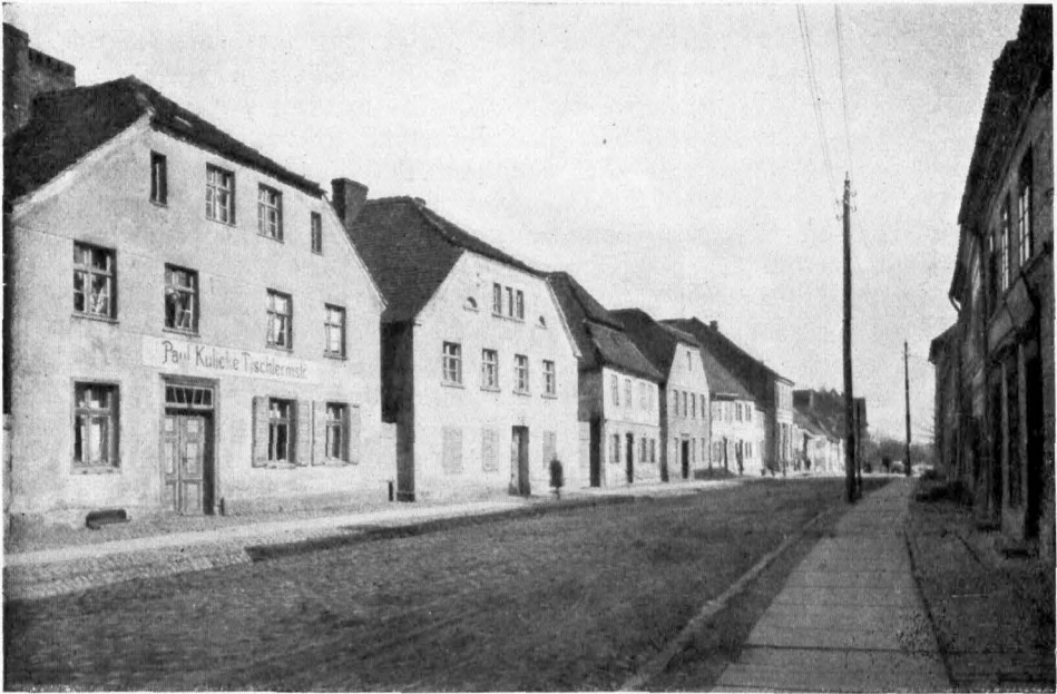
Abb. 9. Wriezen. Alte Häuser in der Jägerstraße (Aufnahme 1927)
