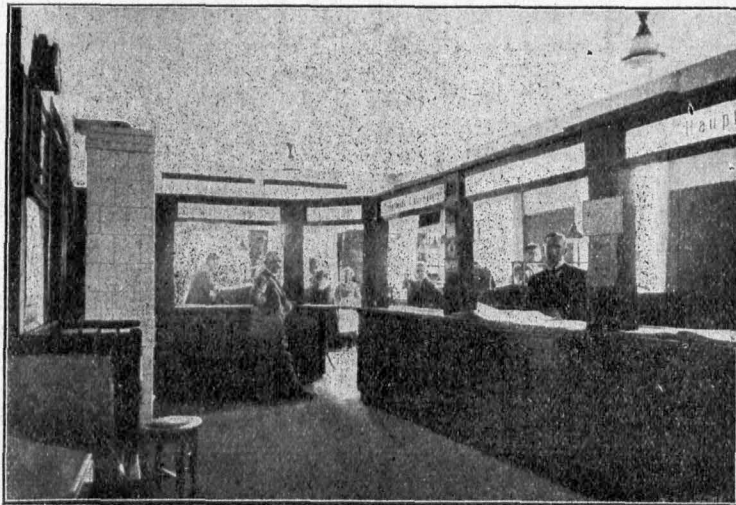
Blick in den Abfertigungsraum der Oberbarnimer Kreispar-kasse in Freienwalde a. D.
