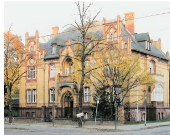
mitte Villa Tummeley unten links ehem. Kasino unten rechts ehem. Offiziershaus
