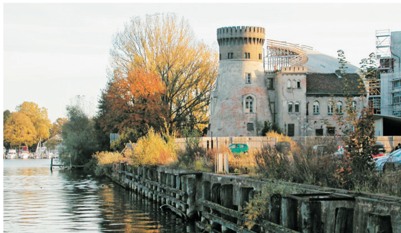
oben Koksseparation und Zichorienmühle, 2001 unten heutige Ufersituation am Tiefen See
