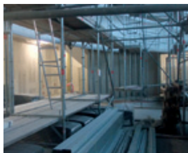
Baumaßnahmen im Lesesaal. Fotos: BLHA.
