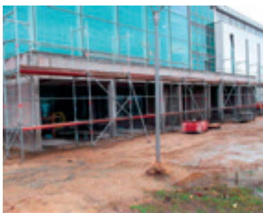
Baumaßnahmen im Eingangsbereich.
