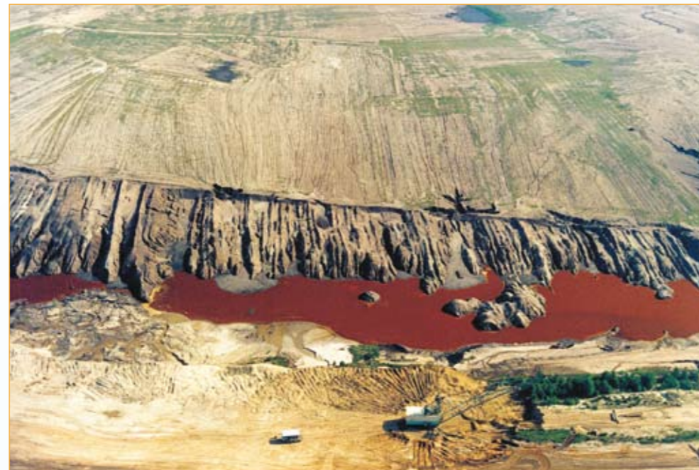
Sanierungsarbeiten am Randschlauch 1996
