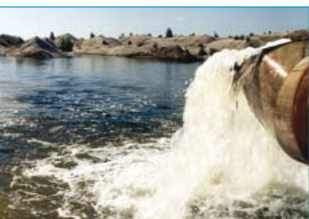
Flutung Speicherbecken Lohsa
