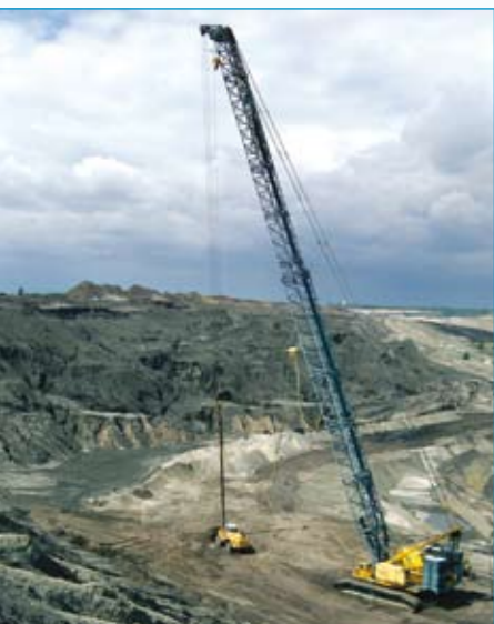
Rütteldruckverdichtung
