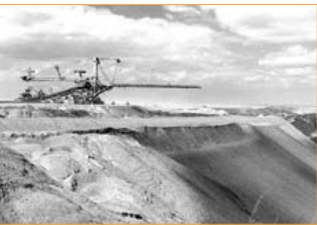
Absetzer beim Einsatz in der Sanierung
