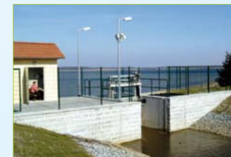
Einlaufbauwerk Tagebau Burghammer 2006
