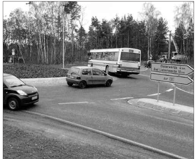
Neuer Kreisverkehrsplatz am Knoten Elsterwerda/Biehla bringt Autofahrern mehr Übersicht.
