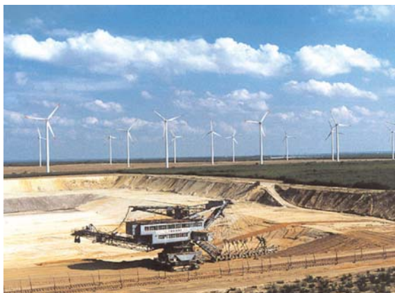
Windkraftanlagen (Foto: LMBV)
