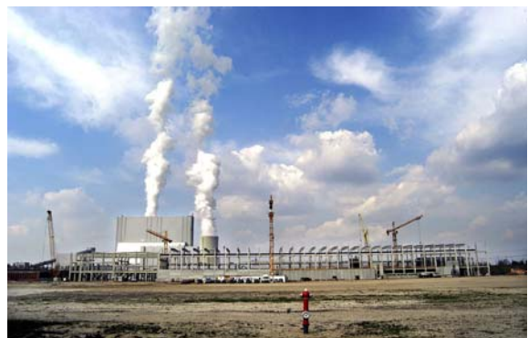
Sanierungsstandort Schwarze Pumpe - Bau einer Papierfabrik - (Bild: LMBV)
