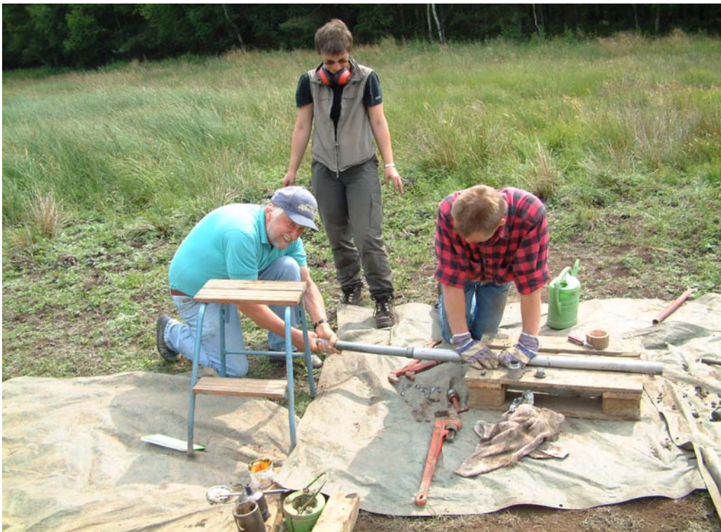
Arbeiten an einer der Bohrungen des Projekts Tschernitz, das mit den Kollegen des LfUG/Freiberg (Sachsen) gemeinsam geplant und durchgeführt wurde
