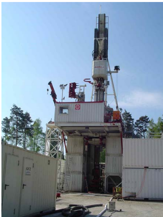
Neuartige Bohranlage in Groß Schönebeck
