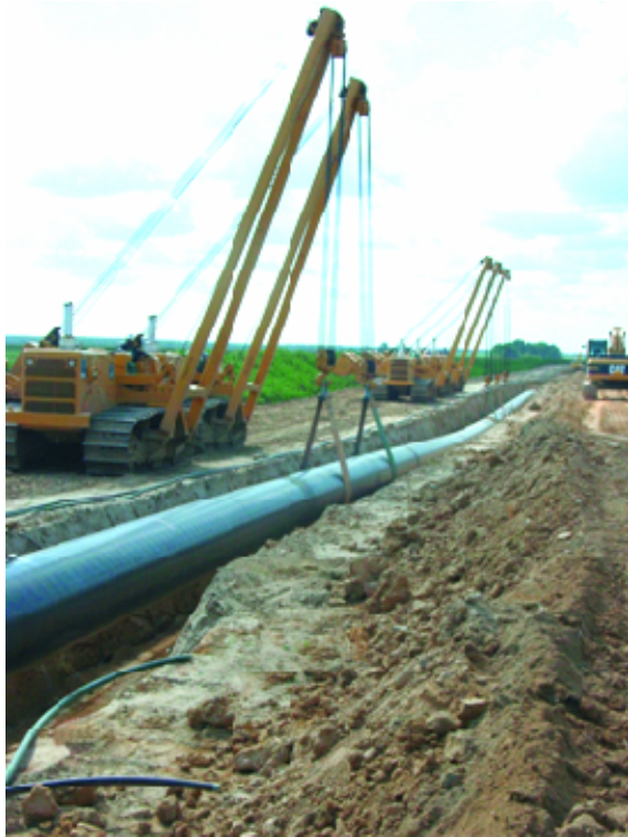
Errichtung FGL 306 – Inbetriebnahme (Foto: LBGR / 01.04.2004)
