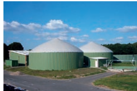
Biogasanlage mit Trocken-Nass-Simultan-Vergärung in Pinnow
