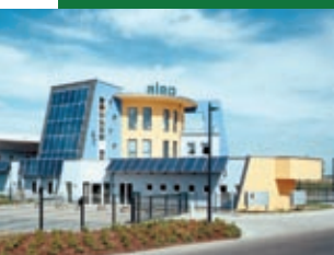
Modulfabrik der aleo solar AG in Prenzlau
